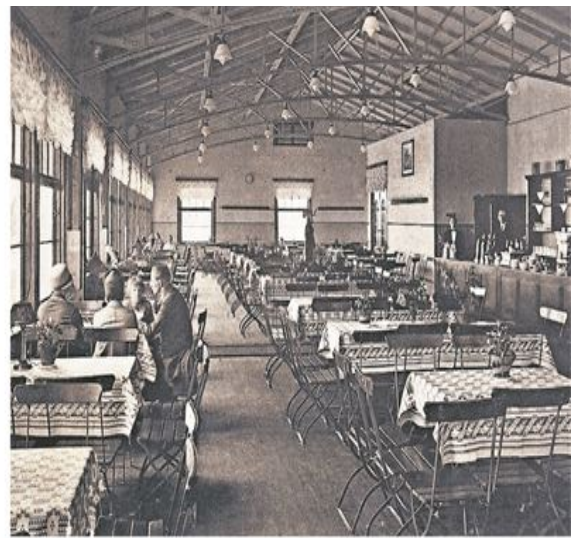
Der Innenraum der Nordenhamer Strandhalle im Jahr 1929 mit Blick auf den Weserstrand. Archiv Winkler
